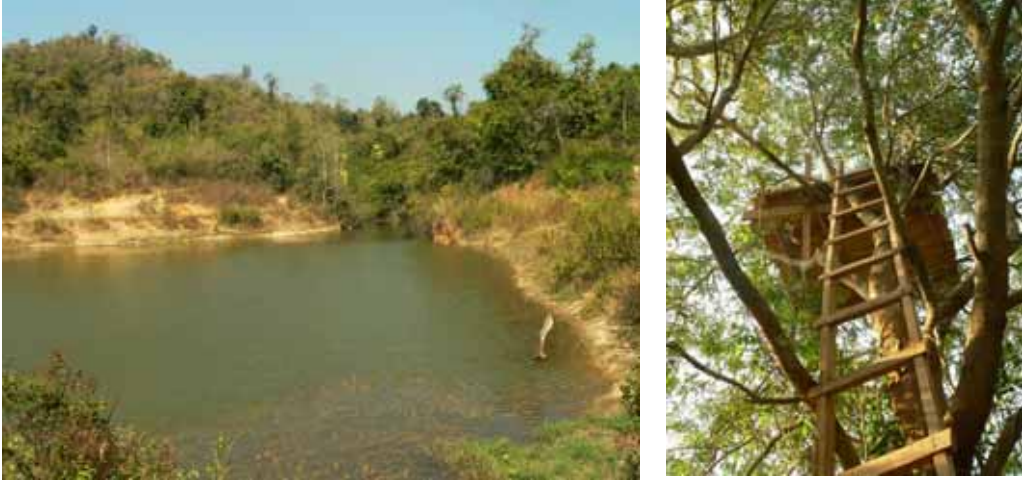
ภาพที่ 14. การจัดสร้างฝายน้ำล้น แหล่งน้ำถาวรสำหรับช้าง และสัตว์ป่าต่างๆ และการสร้าง หাঁงบนต้นไม้สำหรับการสังเกตติดตามเก็บข้อมูล หรือชมช้างป่าในบริเวณป่ากุยบุรี
