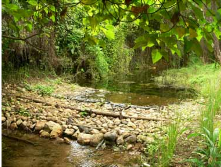
ภาพที่ 12. ฝ่ายแม้ว เป็นฝ่ายชะลอน้ำ เพื่อกักเก็บน้ำในหน้าแล้งสำหรับข้างป่า
